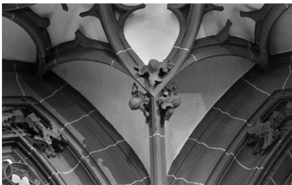
Abb. 93 Bartholomäuskirche Frankfurt, Gewölbe der Turmhalle
