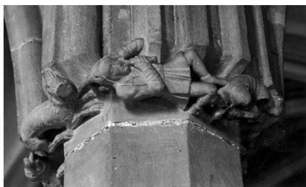
Abb. 95 Peterskirche Görlitz, Georgenkapelle, Mittelstütze
