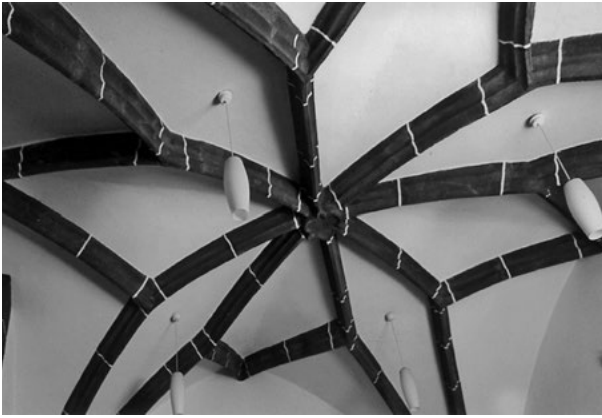
Abb. 130 Dorfkirche Auerswalde, diagonaler Achtrautenstern
