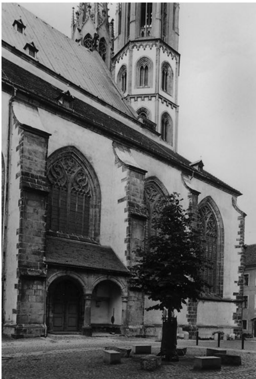
Abb. 18 Peterskirche Görlitz, nördliche Strebepfeiler
