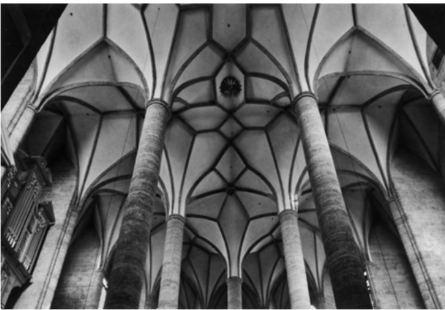
Abb. 185 Klosterkirche Salzburg, Chorgewölbe
