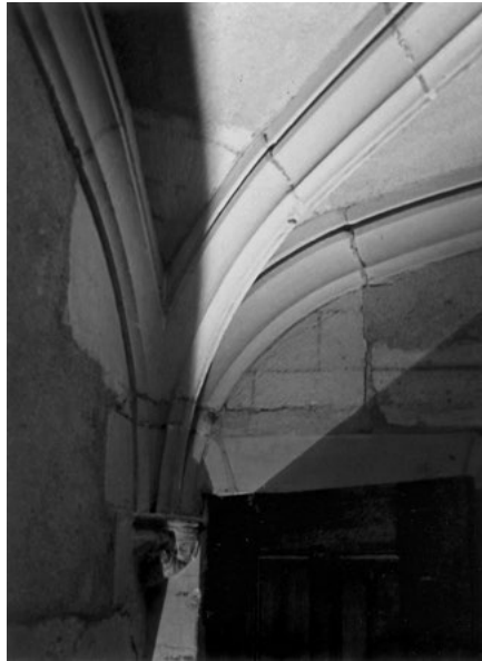
Abb. 61 Palais Jacques Coeur Bourges, Rippen mit doppelter Kehlung
