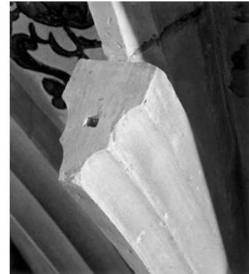
Abb. 62 Marienkirche Pirna, Rippe mit doppelter Kehlung
