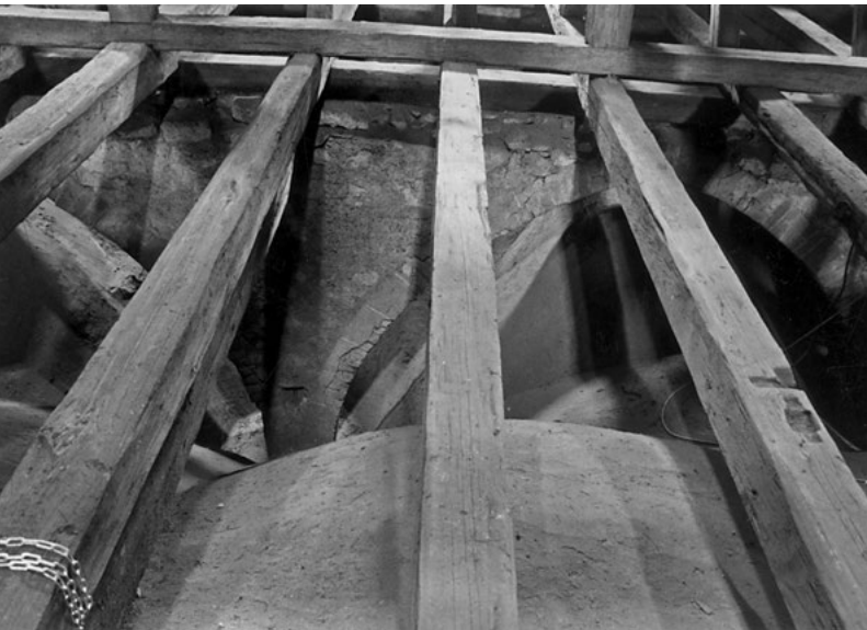
Abb. 21 Petrikerche Rochlitz, Scheidbögen über dem Mittelschiffgewölbe
