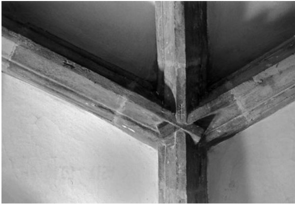
Abb. 65 Marienkirche Marienberg, Rippen mit Durchsteckungen und gekappten Endungen
