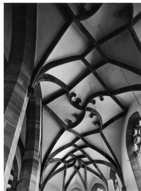
Abb. 158 Katharinenkirche Zwickau, Südschiffgewölbe mit Maßwerk
