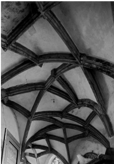
Abb. 65 Marienkirche Marienberg, Rippen mit Durchsteckungen und gekappten Endungen
