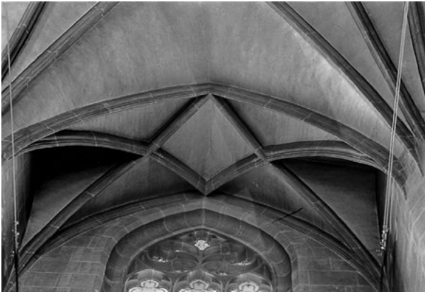
Abb. 146 St. Martin Amberg, Doppelkreuzgewölbe zwischen den Wandpfeilern
