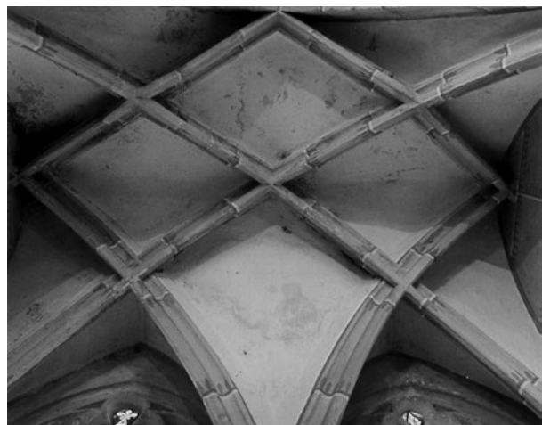
Abb. 144 Schlosskirche Altenburg, Emporengewölbe
