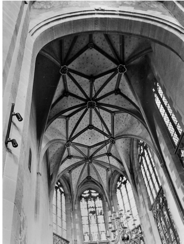
Abb. 113 St. Leonhard Frankfurt, Chorgewölbe
