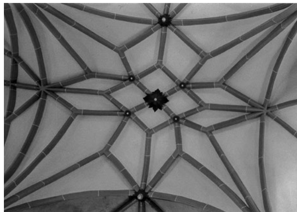
Abb. 137 Jakobikirche Oelsnitz/Vogtland, Gewölbe
