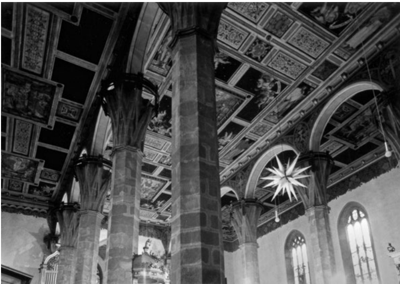
Abb. 20 Nikolaikirche Geithain, Freipfeiler mit Scheidbögen
