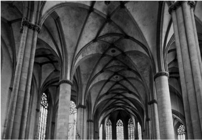
Abb. 184 St. Lamberti Münster, Langhausgewölbe
