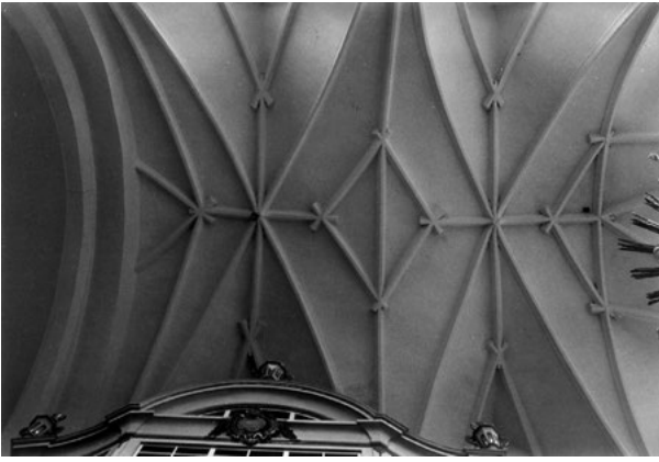
Abb. 69 Kirche Bärenstein, Chorgewölbe mit durchsteckten Rippen
