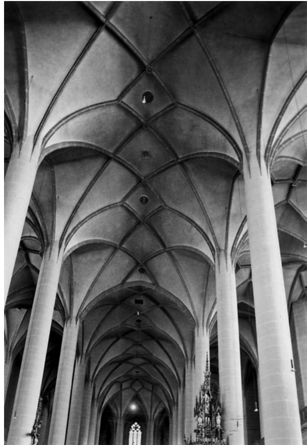
Abb. 183 St. Martin Amberg, Langhausgewölbe mit Scheidrippen
