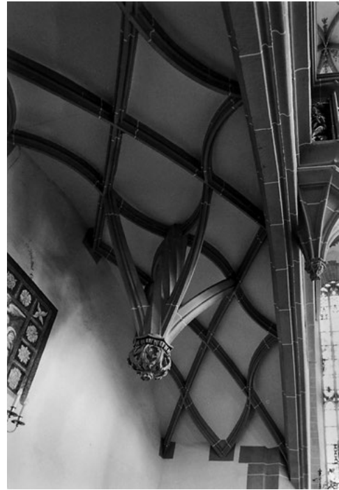
Abb. 104 Annenkirche Annaberg, Emporengewölbe mit hängendem Schlussstein
