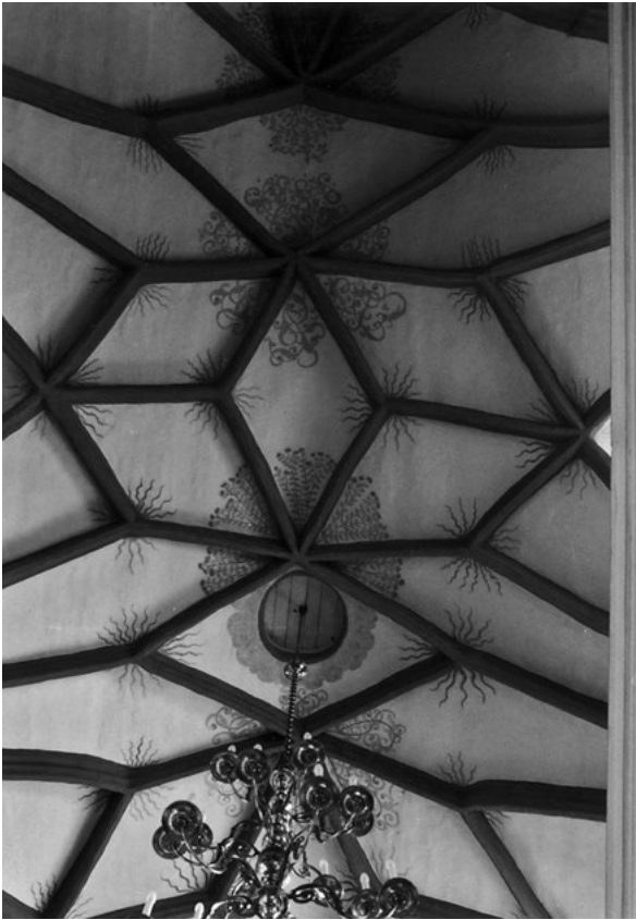
Abb. 177 Kirche Podelwitz, Gewölbeöffnung mit Gewölkmalerei
