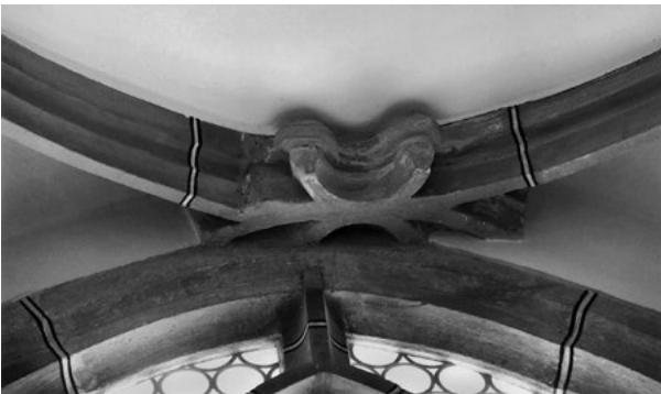
Abb. 71 Görlitz, Peterstraße 8, Rippendurchdringungen
