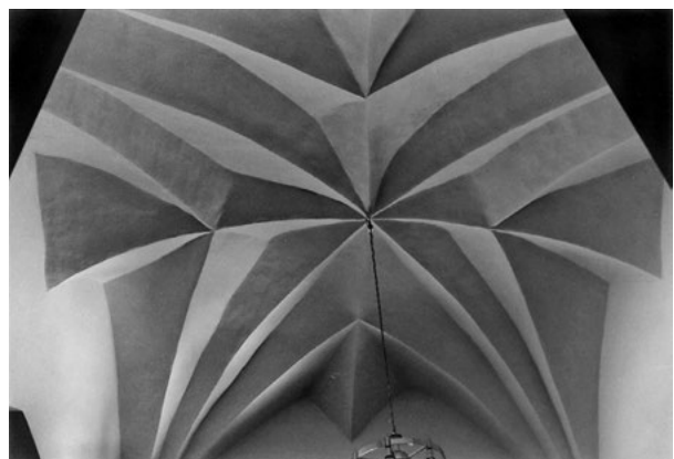
Abb. 114 Nikolaikirche Döbeln, Zellengewölbe im Turm
