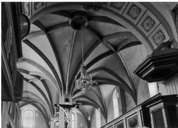
Abb. 121 Kirche Hirschfelde, Knicksterngewölbe mit schirmartiger Wirkung im Langhaus
