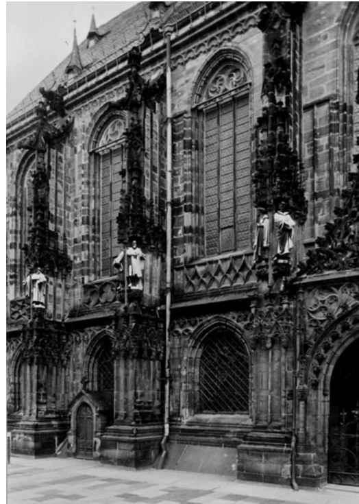
Abb. 17 Marienkirche Zwickau, nördliche Strebepfeiler
