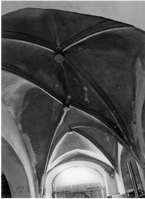
Abb. 117 Görlitz, Peterstraße 16, Springgewölbe
