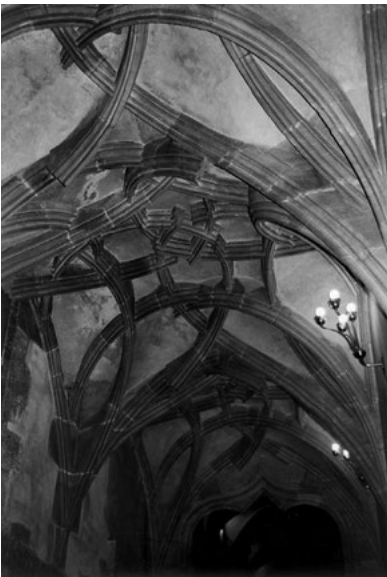
Abb. 69 Kirche Bärenstein, Chorgewölbe mit durchsteckten Rippen
