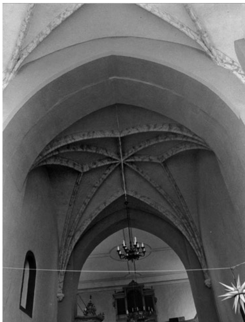
Abb. 124 Marienkirche Geithain-Wickershain, Vierrautenstern im Chorturm
