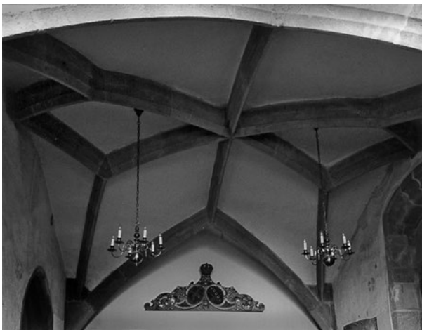
Abb. 128 Schlosskapelle Rochlitz, Sechsrautenstern
