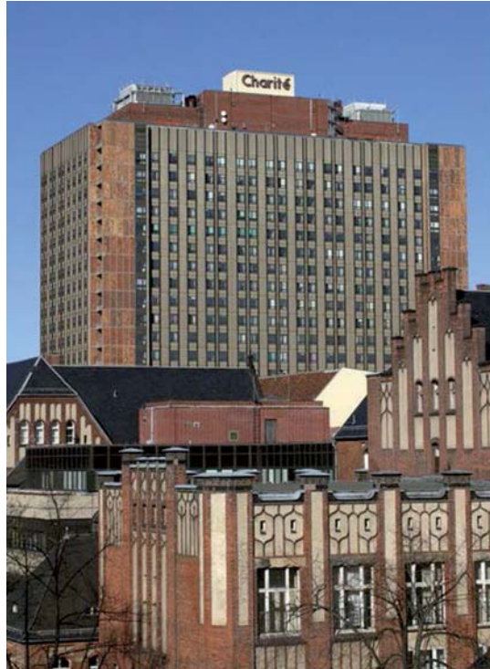
Campus Charité Mitte vor Sanierung 2013
