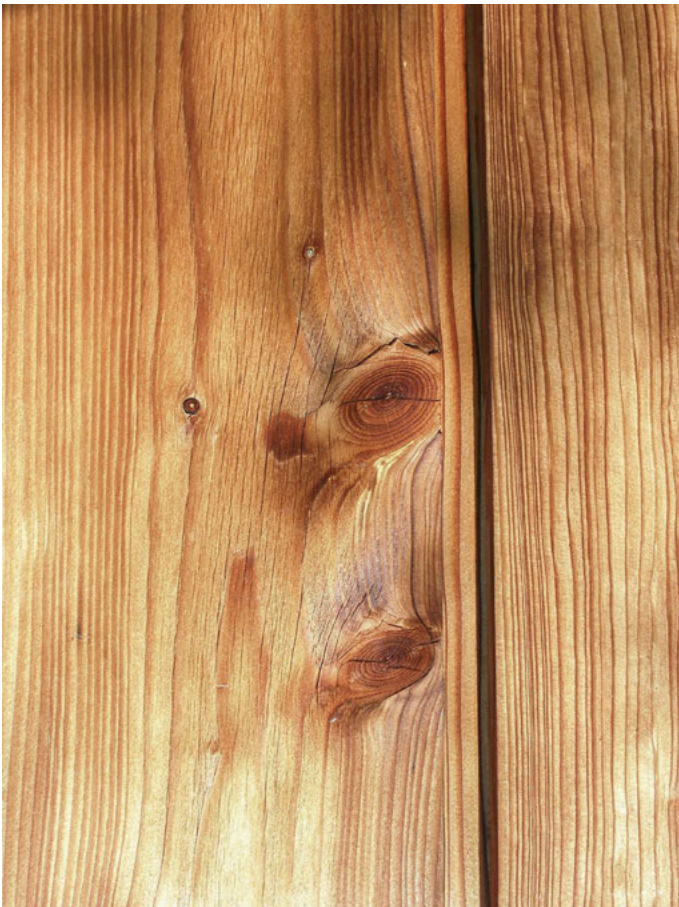
Unbehandeltes Lärchenholz im Außenbereich trotz der Witterung aufgrund seines hohen Harzgehaltes. Dauerhafte Sonneneinstrahlung gibt dem Holz die typische rötliche Färbung.
