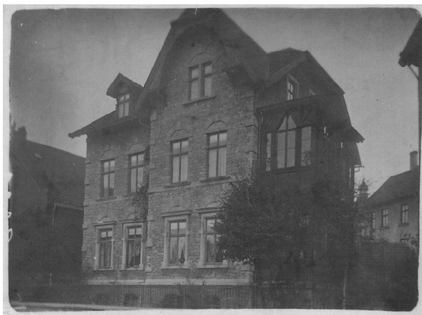
Abb. 3: Das Haus in der Leopoldstraße.
