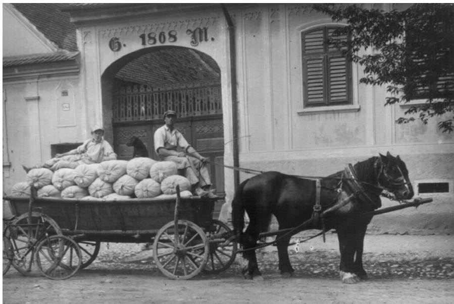
Abb. 2: Das Tor des Großelternhauses mütterlicherseits in Rosenau/Riřnov im Jahr 1938.
