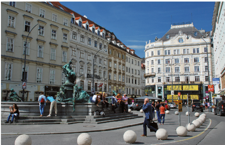
Der „Donnerbrunnen“ (Providentia-Brunnen von Georg Raphael Donner), wie er nach Bau der Tiefgarage wieder aussehen soll ...
