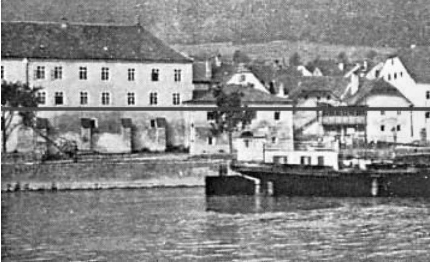
Abb. 4: Das alte Zollhaus (Mitte) und neue Zollhaus (links) von Engelhartzell an der Donau (Oberösterreich). Foto: Siegfried Schwarzl, 1954, entnommen aus Rohr: Extreme Naturereignisse , S. 377. Das neue Zollhaus ist so hoch gebaut, dass das Niveau des ‚Jahrtausendhochwassers‘ von 1501 (Linie auf der Basis der Hochwassermarke knapp unterhalb des Daches des alten Zollhauses) dessen Fenster nicht erreicht hätte.
