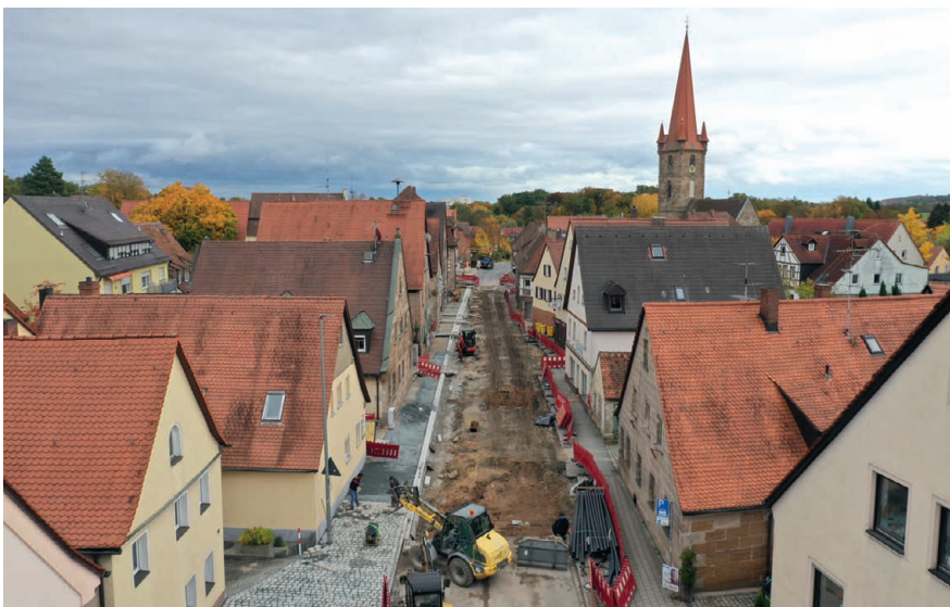
Drohnenaufnahme des freigelegten Bohlenwegs in Burgfarnbach.
