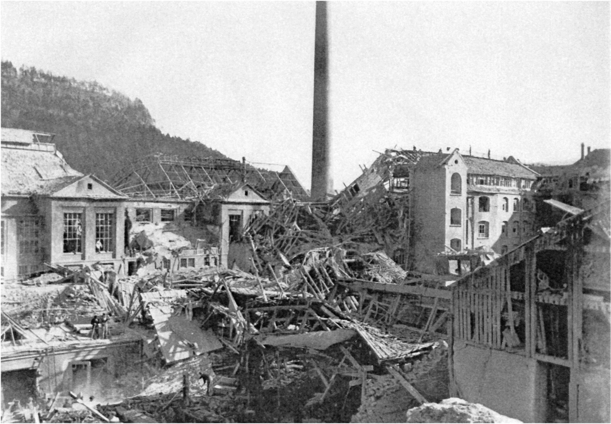
Störung der Rüstung: Schäden an Mausers Kraftwerk (links des Schornsteins), der Zentrale (rechts) und dem Mittleren Werk (im Vordergrund) nach Feindeinwirkung vom 22. Februar 1945
