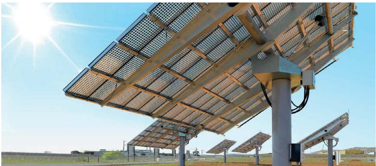
Konzentratorsysteme der Firma Concentrix mit FLATCON® Modulen und Tripelsolarzellen.
