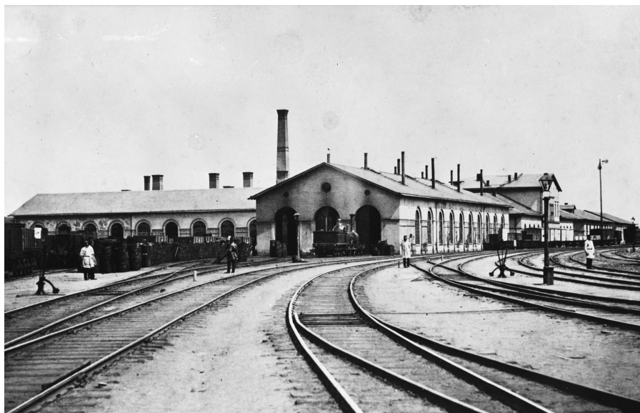
Die Lokomotivremise mit der Wagenwerkstatt des Dresdener Bahnhofs in Leipzig.
