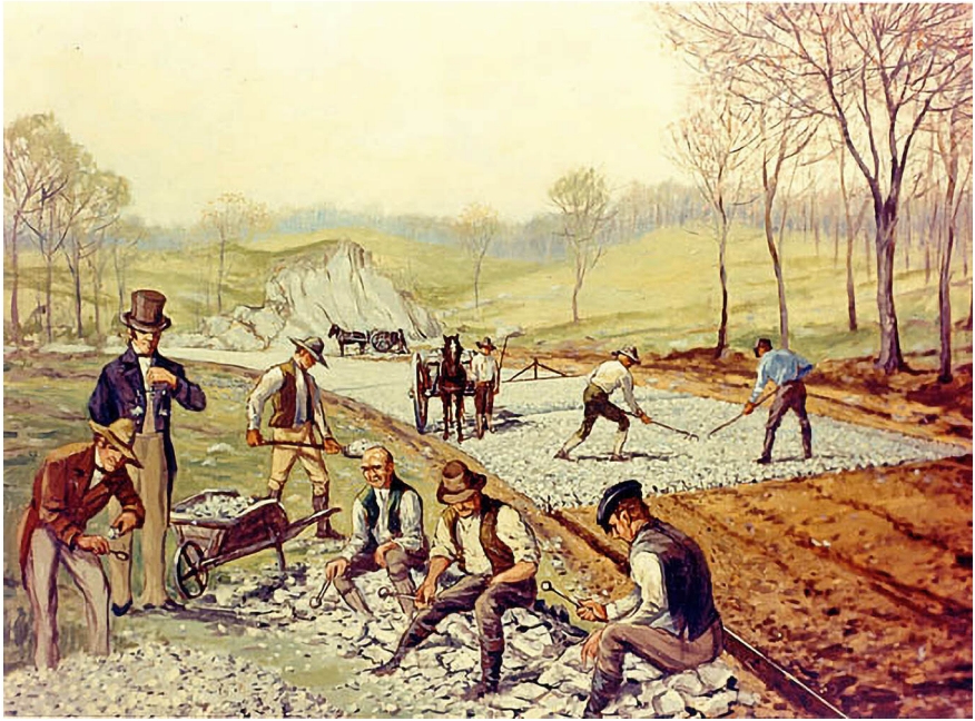
Abb. 1: Arbeiten an der ersten Straße in den USA, die im Jahre 1823 nach den Methoden McAdams gebaut wurde.
