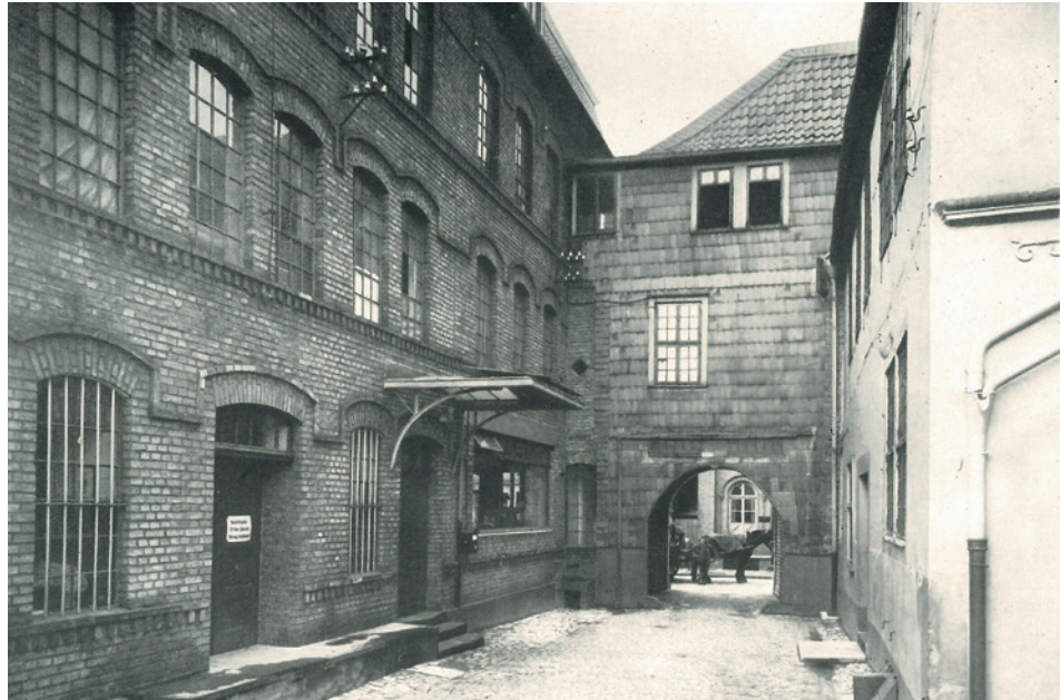
Hofansicht des Geschäftshauses in der Güsenstraße, Bielefeld
