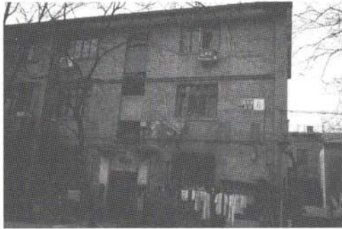
Abbildung 2–3: „Bruchstellen“ – Wohnbebauung Baiwanzhuang (r.) und Sanlihe (u.)
