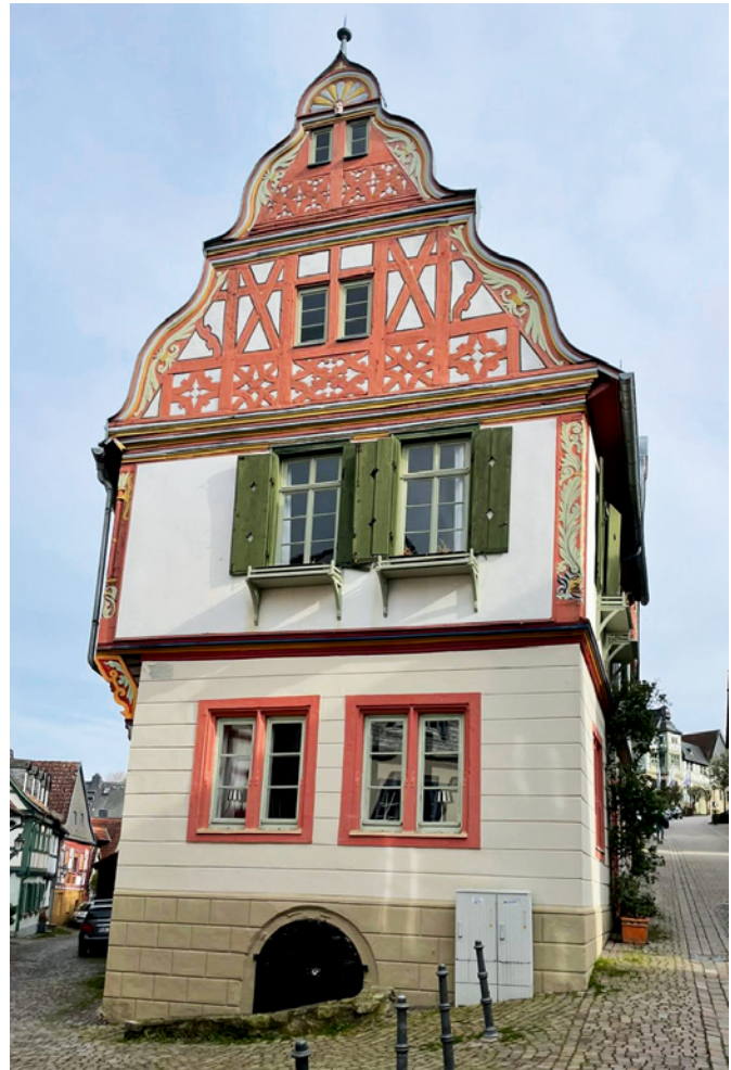
Abb. 1.2: Renaissance-Fachwerkhaus in Idstein. Das gesicherte barocke Erscheinungsbild wurde auf Grundlage einer eingehenden Bauforschung wiederhergestellt, indem das wenige Jahrzehnte zuvor freigelegte und auf einen ungesicherten älteren Zustand veränderte Fachwerk im Obergeschoss erneut verputzt wurde – linker Abbildungsteil: Zustand der Fassade in den 1980er-Jahren; rechter Abbildungsteil: Zustand der Fassade 2002. (Quelle: Privatarchiv Steckel)
