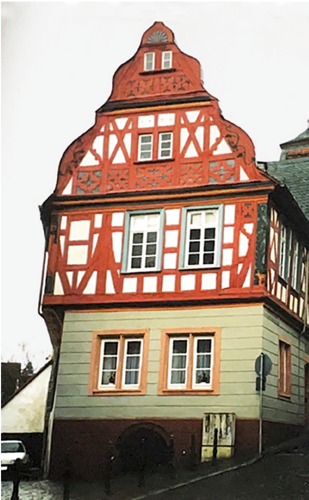
Abb. 1.2: Renaissance-Fachwerkhaus in Idstein. Das gesicherte barocke Erscheinungsbild wurde auf Grundlage einer eingehenden Bauforschung wiederhergestellt, indem das wenige Jahrzehnte zuvor freigelegte und auf einen ungesicherten älteren Zustand veränderte Fachwerk im Obergeschoss erneut verputzt wurde – linker Abbildungsteil: Zustand der Fassade in den 1980er-Jahren; rechter Abbildungsteil: Zustand der Fassade 2002. (Quelle: Privatarchiv Steckel)
