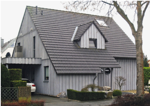
Abb. 1.8: Beispiel für ein in Holzrahmenbauweise erstelltes Haus
