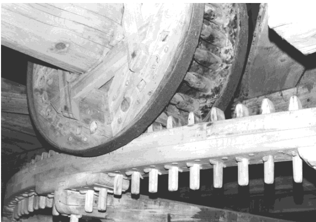
Bild 1/3 Wasserförderungsanlage mit Göpelantrieb; Brunnenanlage Augustusburg, Sachsen (etwa 1575)
