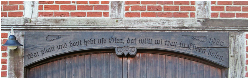
Torbalken der Olen Schüne in Drakenburg
