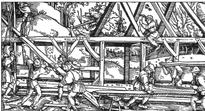
Bild 1.2 Petrarca: Bau eines Fachwerkhauses um 1520
