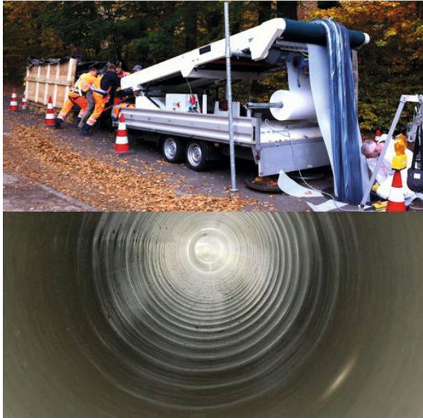
**Bild 1.11** Sanierung von Abwasserkanälen mit Schlauchlinern [Bildquelle: Firma RelineEurope [14]]
