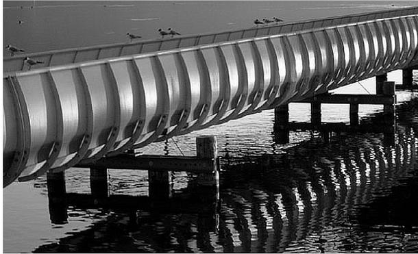
**Bild 1.7** Brückenkonstruktion aus GFK [11]
