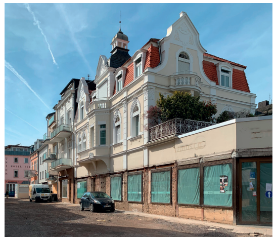
Bild 2.2: Sanierung von Geschäftsräumen
