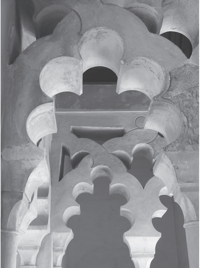
Die Ruinen der maurischen Burg von Málaga wurden bis in die Details hinein restauriert.
