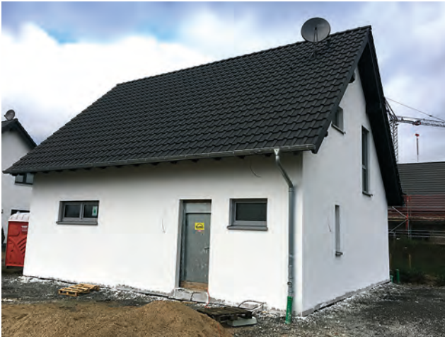
Bild 10: Passivhaus, welches in Holzrahmenbauweise errichtet wurde; GK 1a
