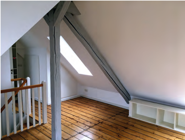
Bild 6: Pfettendach mit freilegender Stütze und Sparre (modernisierter Altbau)
