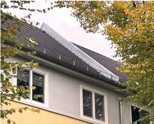
Bild 1: Brandwand (hier bei einem Mehrfamilienhaus)
