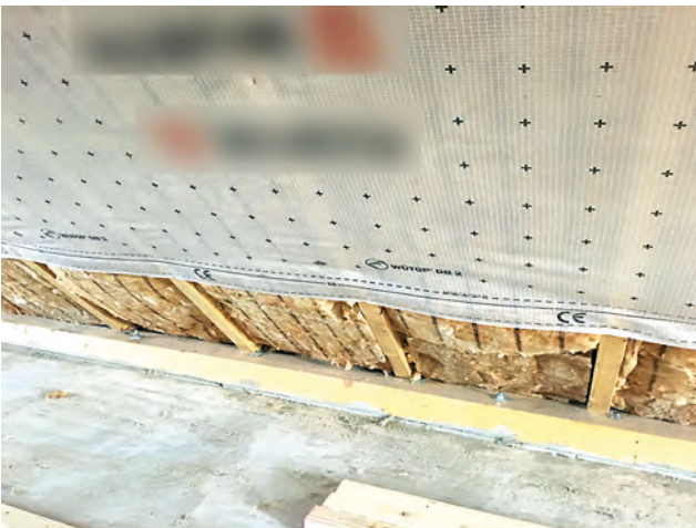
Bild 4: Dampfsperre (Folie) mit der dahinterliegenden Zwischensparrendämmung (Steinwolle)
