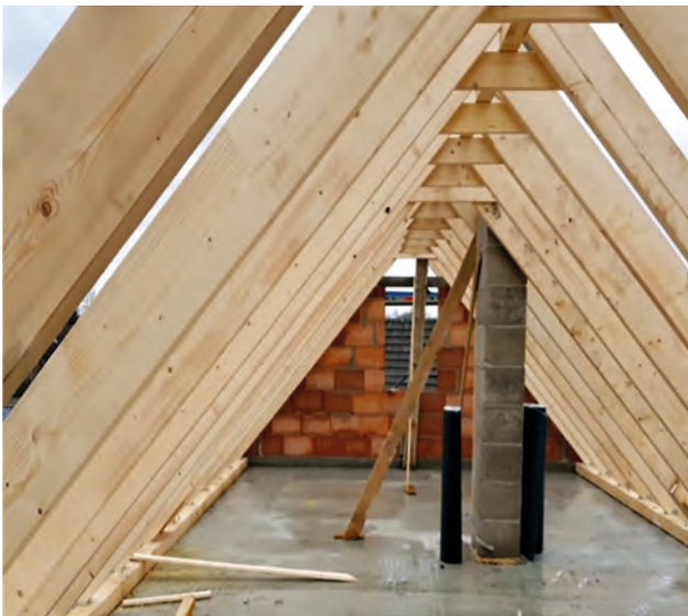
Bild 5: Sparrendach eines Neubaus mit geradem Schornstein
