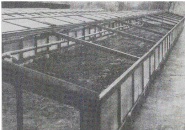
Abb. 4. Geschlossene Firstlüftung mit dem darunter befindlichen U-Profil als Anschlag
