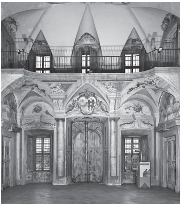
Abb. 22 Borgo a Buggiano, Villa Bellavista, Erdgeschoss, Raum Nr. 1 ( salone ), Blick nach Westen
