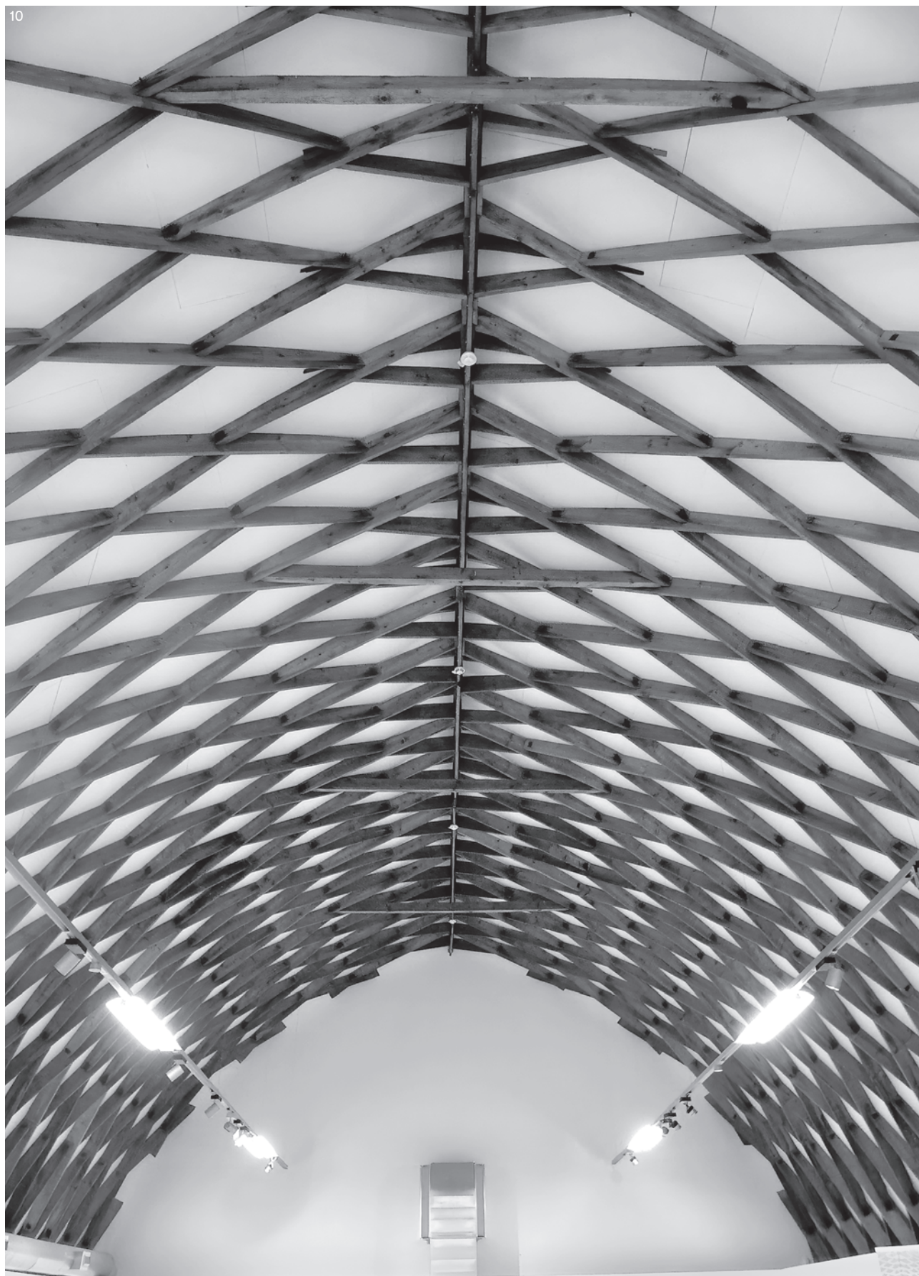
Abb.10 Dach einer Halle im Freilichtmuseum in Glentleiten in Zollinger-Bauweise.
