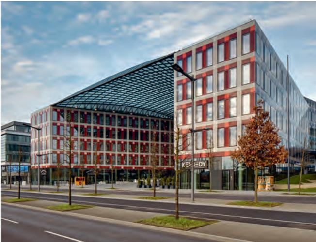
Die Dachgeometrie entstand aus der Verschiebung eines Querbogens entlang eines senkrechten Bogens (Streck-Trans-Fläche). Dabei sind die Öffnungen zwischen den Dachrandträgern und der Trauflinie der beiden Flügelbauten mit geneigten, aber ebenen Glasflächen geschlossen. Diese Modellierung ermöglicht es, das Dach mit transparentem Glas aus einfachen ebenen und viereckigen Verbundsicherheitsglasscheiben einzudecken.
